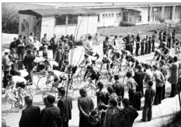
Kryterium uliczne, ul. Obrońców Pokoju
